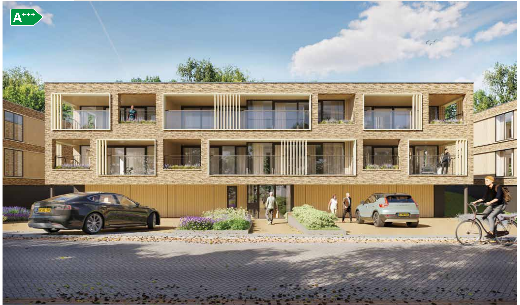
Voor- en entreegevel aan de Botterlaan met privé parkeerplekken en garage
